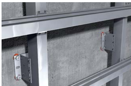
Sub-structuri de fațadă
