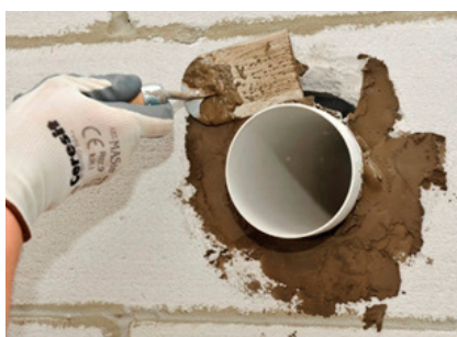
Fixați cu mortarul Ceresit CX 5 Express (umeziți în prealabil suprafața)
