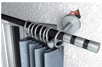
Repararea galeriilor deteriorate
