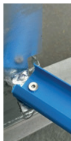
Montarea șinelor de bază piese de racordare
