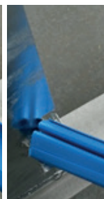
Introducerea șinei de bază la montanțul de oțel
