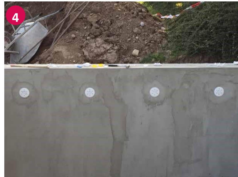
▼ Wichtig: Abdrücken der Rohrleitungen!
