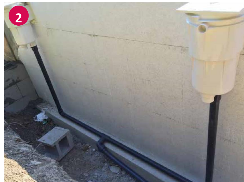
▼ Verrohrung von 2 Skimmer
