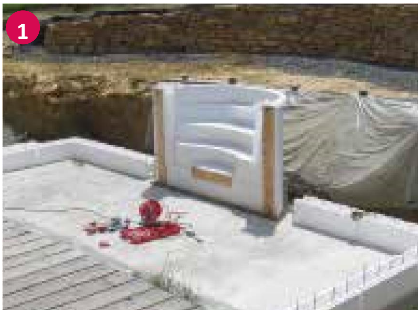
▼ Römertreppe mit erster Ansatzreihe Styroporsteine
