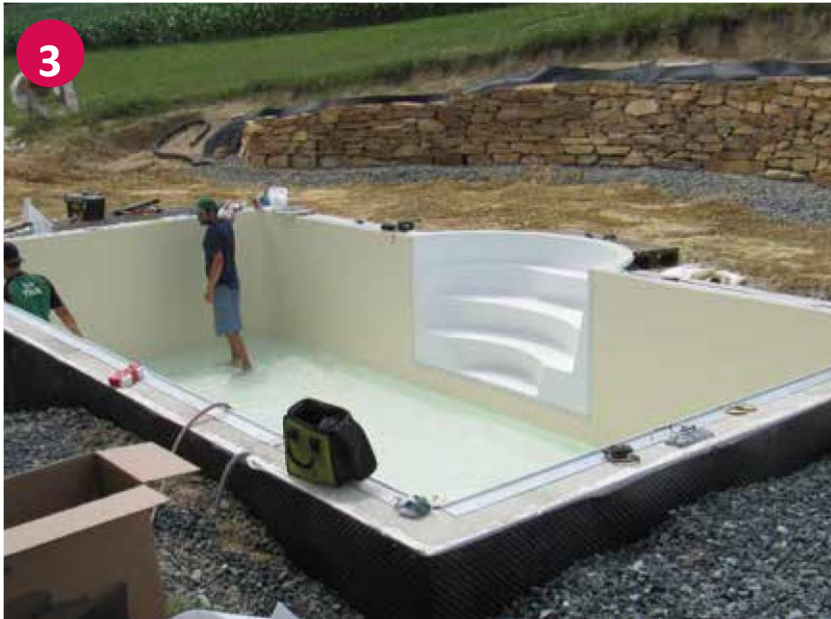
▼ Einhängen des Foliensacks und Anflanschen der Einbauteile
