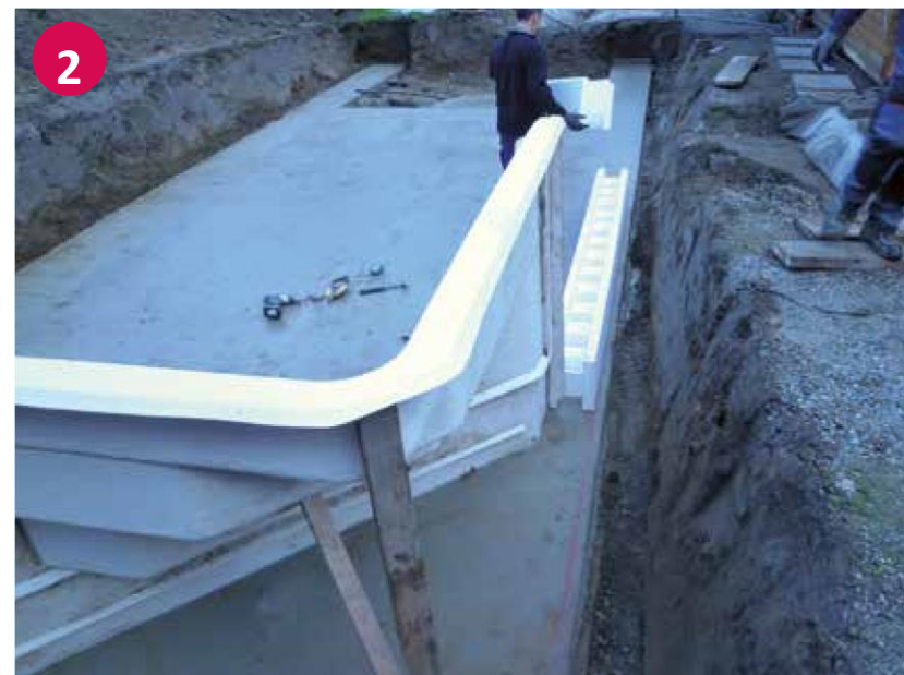
▼ Abstützen sowie senkrecht eund waagerechte Einrichtung der Ecktreppe
