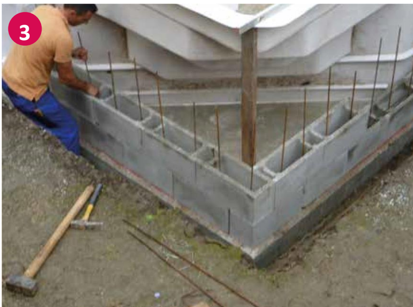
Untermauerung der Ecktreppe
