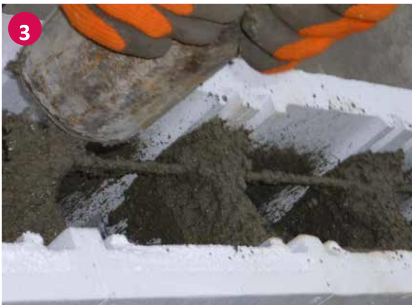
Detailansicht: Ausfüllen der Styroporstein mit dem Beton
