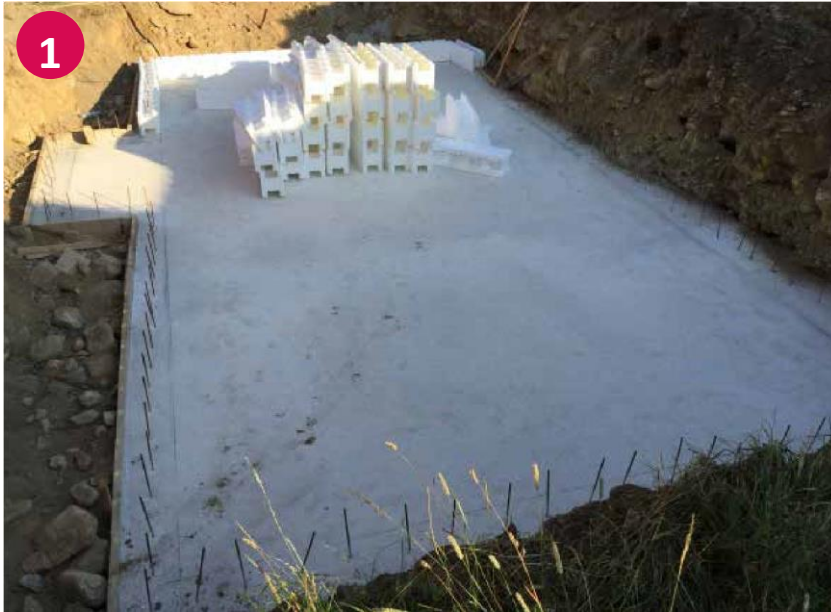
▼ Fertig ausgehärtete Bodenplatte
