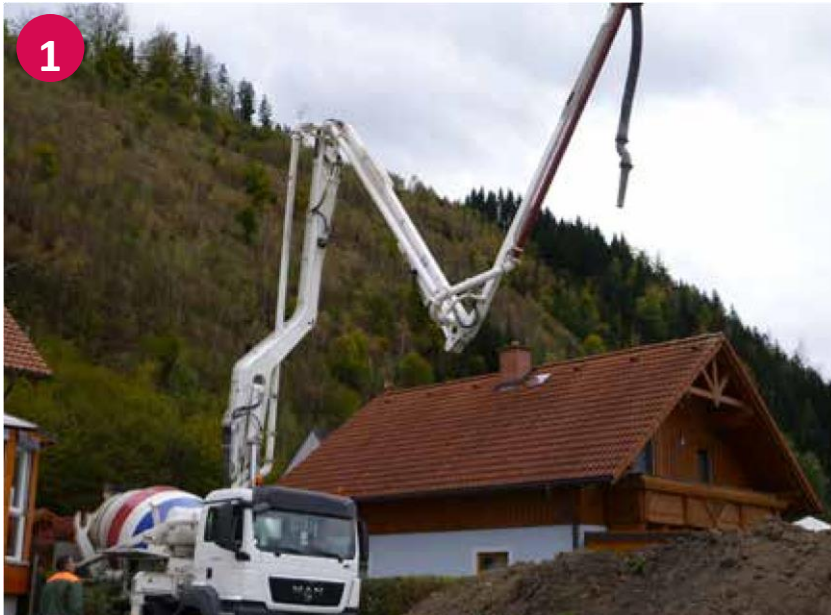
▼ Betonwagen mit Betonpumpe und Fallbremse
