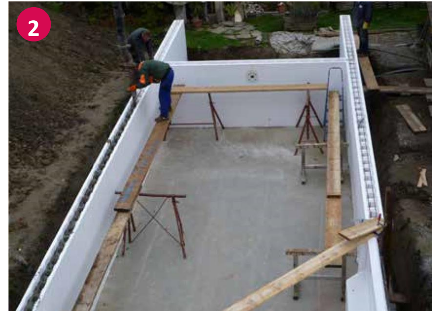
▼ Ausfüllen der Styroporstein mit dem Beton
