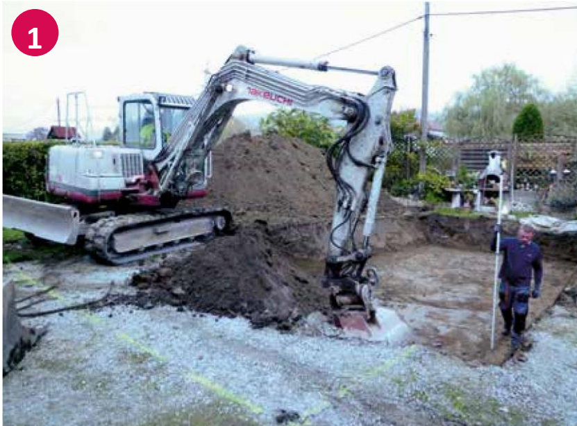
▼ Aushub der Baugrube
