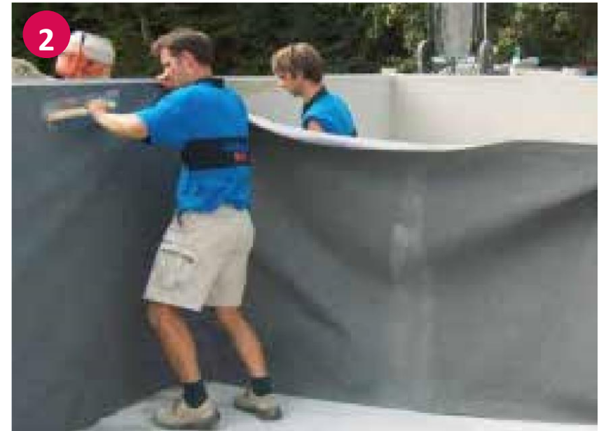
▼ Punktuelle Befestigung der Vliestrennlage mittels Styroporkleber
