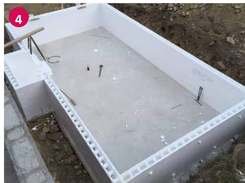
▼ Fertig aufgestelltes Styropor Becken – ohne Betonfüllung
