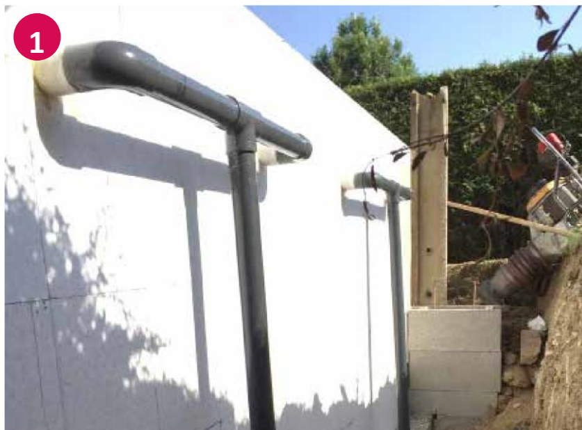
▼ Verrohrung von 4-Düsen
