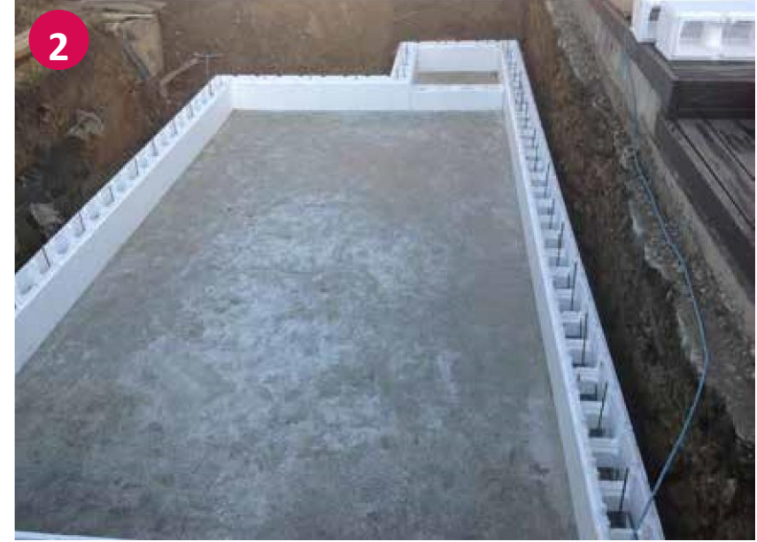
▼ Ansätzen der ersten Reihe Styropor Steine
