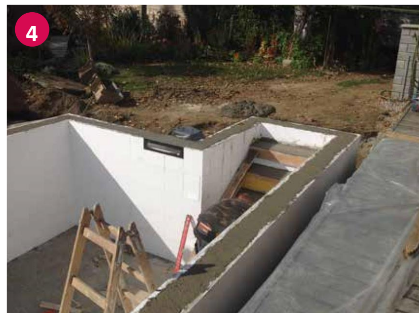
Fertig ausgefülltes Styroporsteinbecken mit Beton
