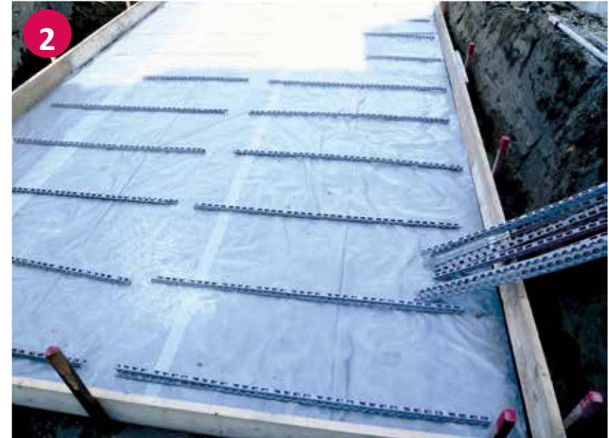
▼ Abschallung der Bodenplatte
