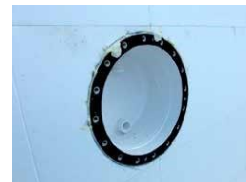
▼ Fertig eingeschäumter Scheinwerfer
