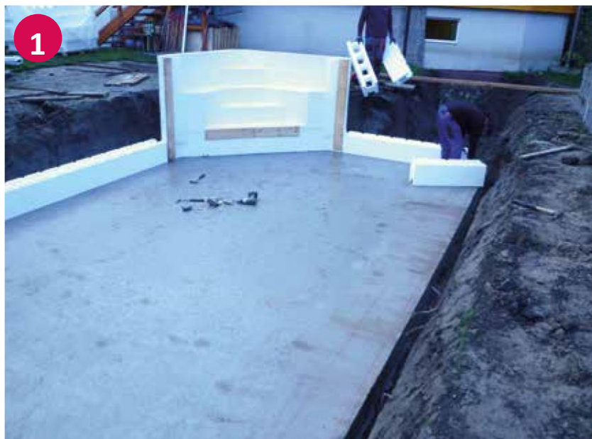
▼ Ecktreppe mit erster Ansatzreihe Styroporsteine
