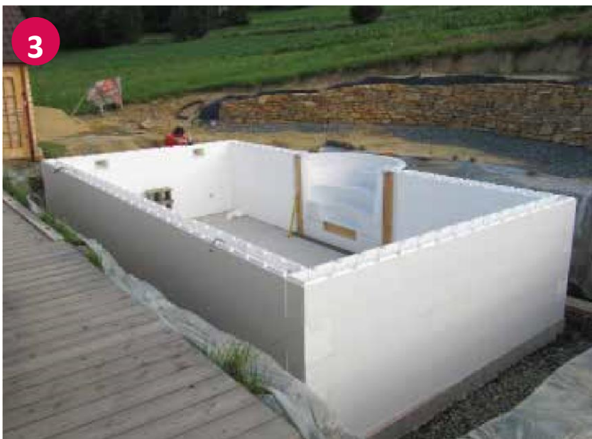
Aufgestelltes Styroporstein Becken mit Römertreppe – ohne Betonfüllung
