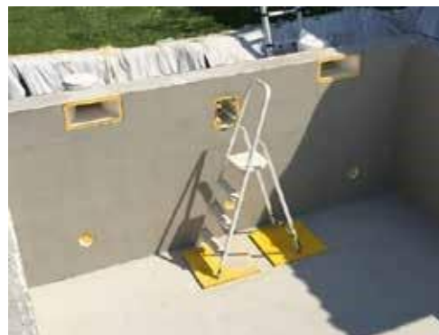
▼ Fertig verspachtelte Innenwand
