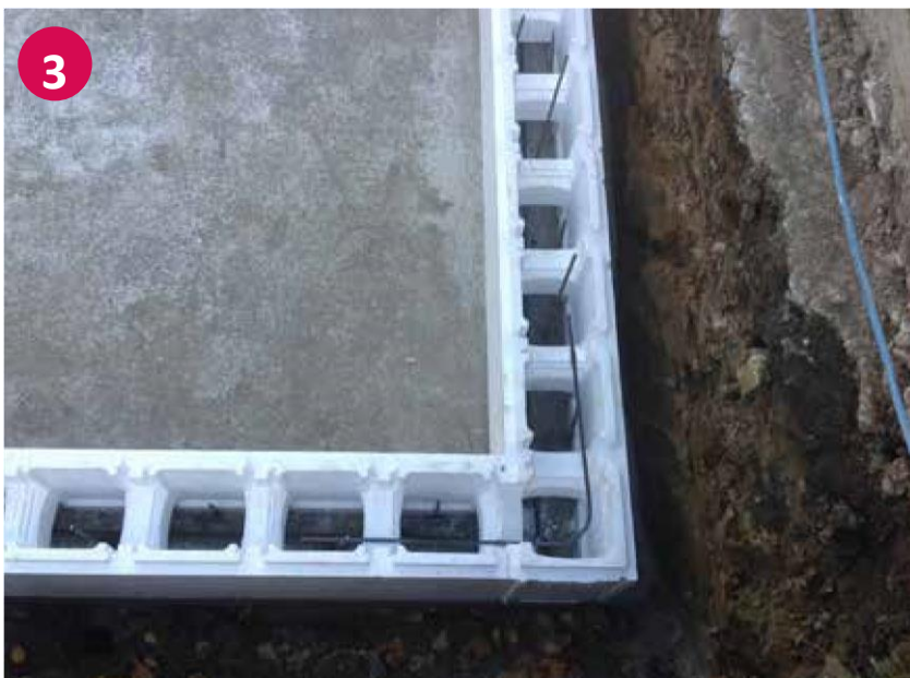
▼ Detailbild einer Eckverbindung samt Eisenarmierung
