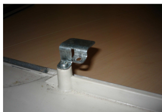
Poziție cleme pentru blaturi de 40mm
