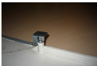
Poziție cleme pentru blaturi de 30mm
