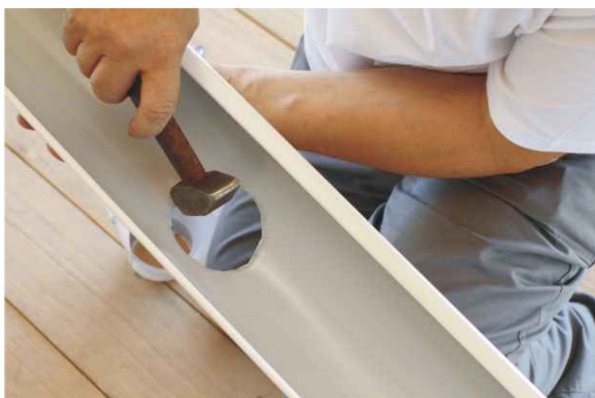
fig. 5989 - Marginea decupată se îndoaie în jos cca. 3 mm pentru a împiedica apa să se prelingă pe partea inferioară a jgheabului.
