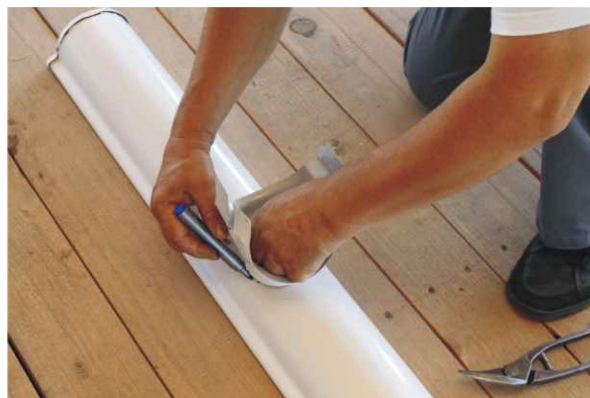
fig. 5982 - Trasarea pe jgheab a zonei ce urmează a fi decupate. După trasare se decupează zona.
