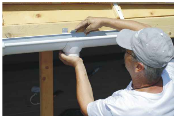
fig. 6106 - Racordul jgheab - burlan se va monta după fixarea jgheabului în cârlige dacă șarpanta are pazie de streășină.
