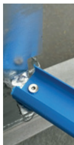
Montarea șinelor de bază piese de racordare
