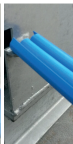
Introducerea șinei de bază la montanțul de oțel
