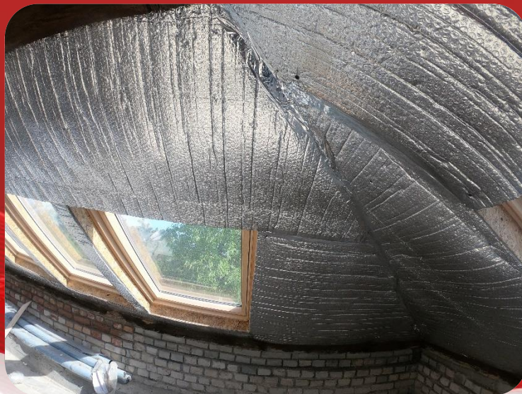
Izolatie pe OSB
