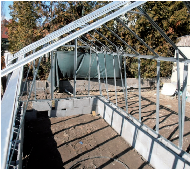
Unghiul de înclinare al acoperișului trebuie să aibă minim 25°
