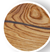
fisuri de capăt și suprafață
