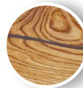
fisuri de capăt și suprafață
