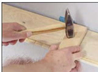
Îmbinați îmbinările capului folosind un ciocan și un bloc de protecție. Îmbinările lungi și cele de cap se vor conecta automat. Continuați această instalare în toată camera.
