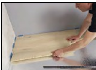
Începeți următorul rând din stânga. Pur și simplu faceți clic pe laturile lungi ale scândurilor împreună. Scândurile nu trebuie să fie lipite.
