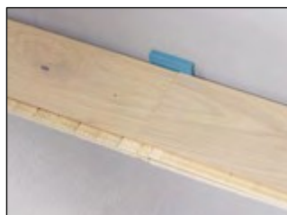
Folosiți distanțierele din plastic pentru a menține o distanță de cel puțin 10 până la 15 mm față de toți pereții și obiectele fixe din cameră.
