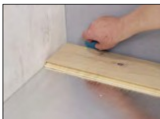
Centrați/inclinați zona de instalare și ajustați primul rând de scânduri tăindu-l la dimensiune.
