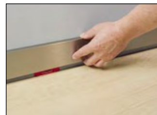
Acoperiți spațiile libere de la margini folosind plinte potrivite din gama extinsă de produse Parador.
