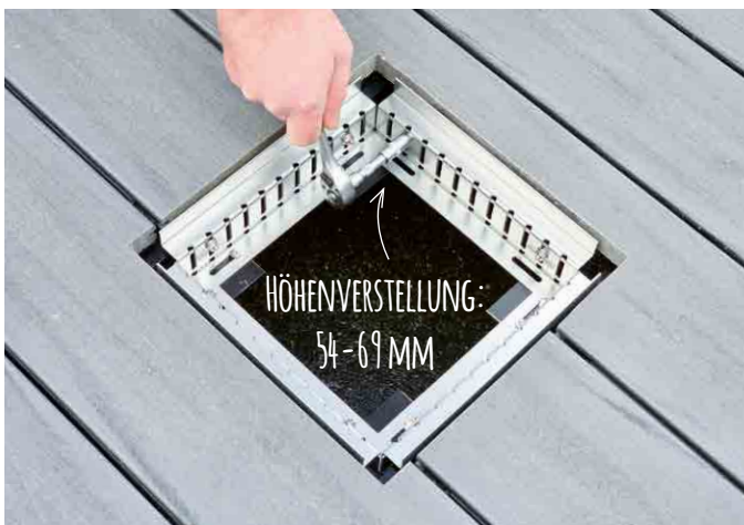
Höhe des Revisionskastens an den Terrassenbelag anpassen.
